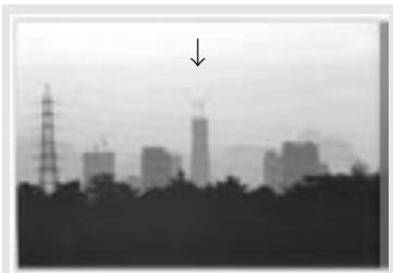
東京スカイツリー 2月 狭山湖堤防より 建設中の電波塔を望む 289m/634m 水越 進
